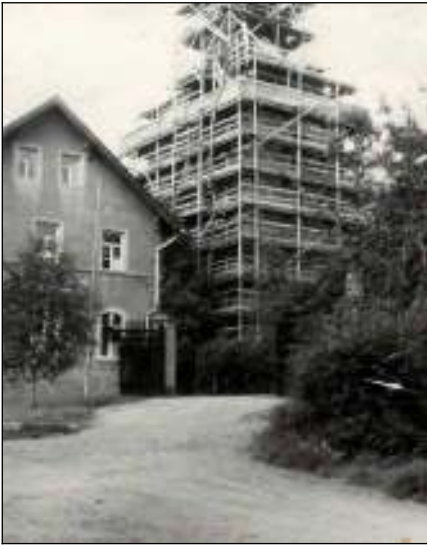
Ein gewaltiges Gerüst – und die Montage des Knopfes und der Wetterfahne durch Kurt Hauschild und einen Helfer.
